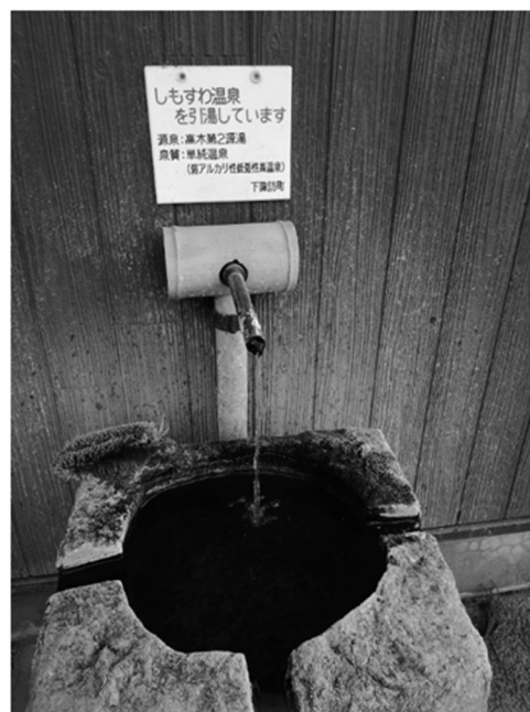
写真2 下諏訪町内 公共水栓 (2022年12月撮影)
